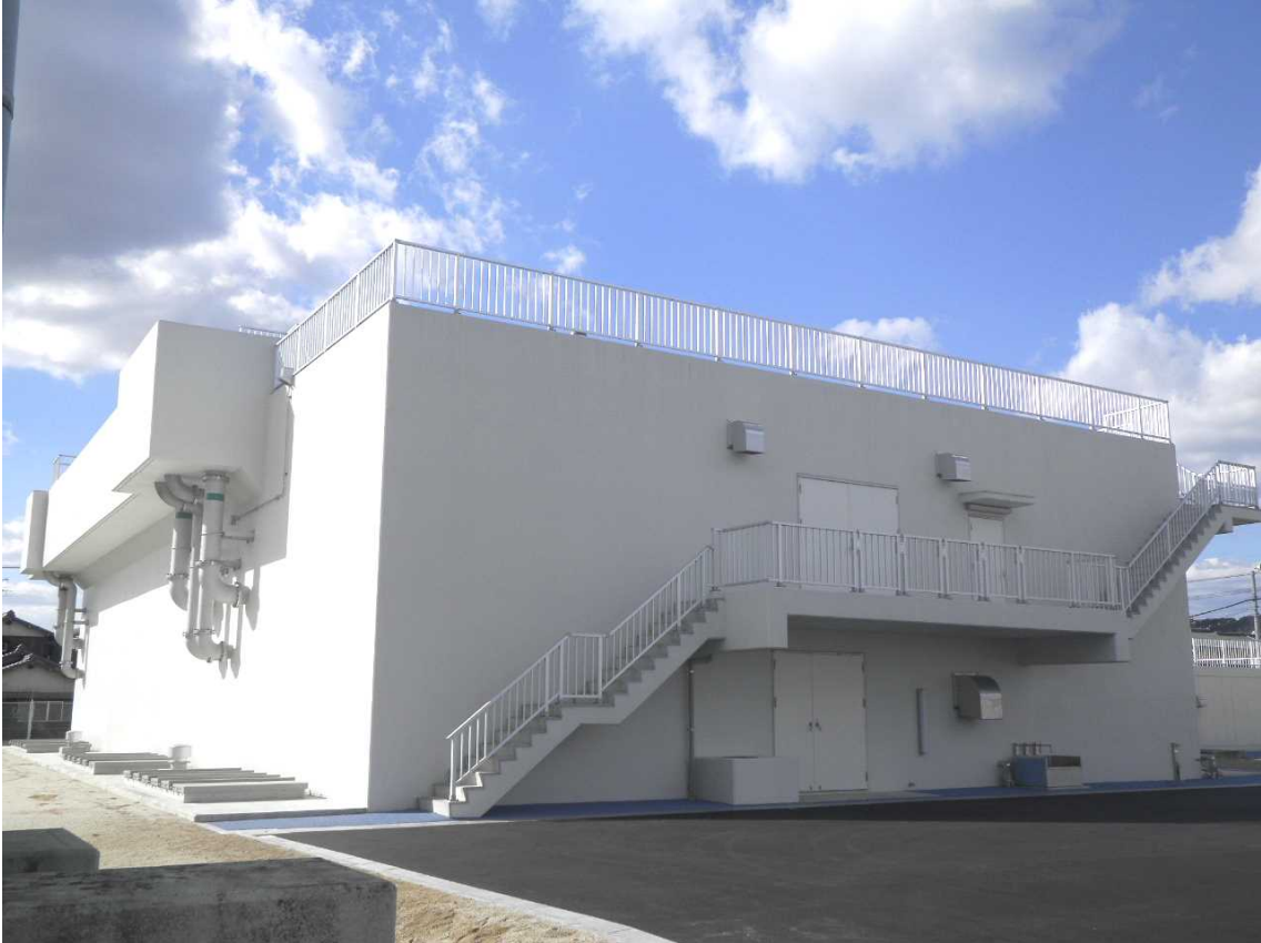
高度浄水処理施設
