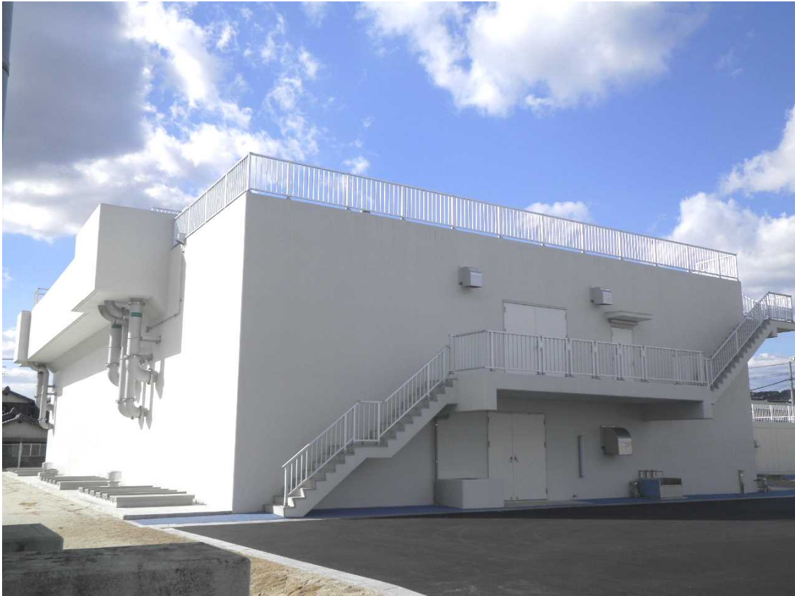
高度浄水処理施設
