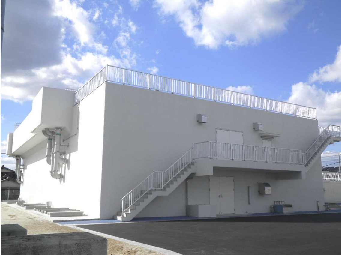
高度浄水処理施設
